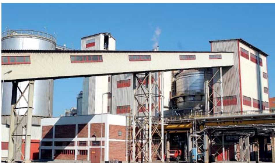
► КЦМ прилага съвременни технологии за производство на цветни метали. Естакада към пържилната пещ
