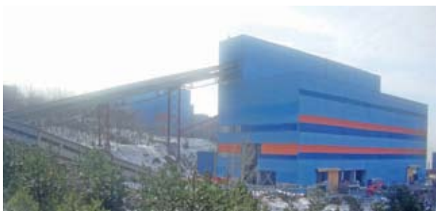
► Реконструкция на корпус "Ситно трошене", "Асарел-Медет"
