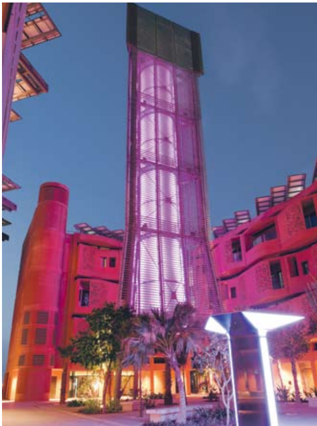
► В Масдарския институт за наука и технологии е изградена вятърна кула за циркулирането на охлаждащ въздух през пешеходните алеи в комплекса
