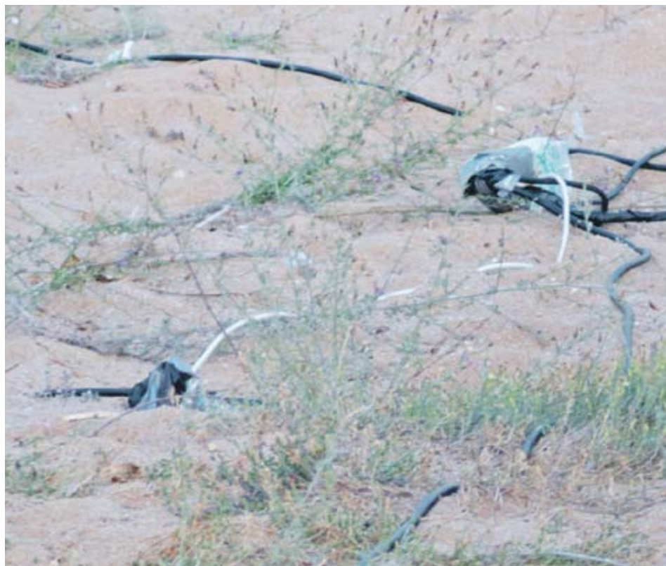
► Караваните на плажа са свързани с електрическата мрежа чрез разклонители, които са съединени един с друг с тиксо и найлонови торбички. Не е ясно дали при по-силен дъжд например това няма да предизвика пожар или друга неприятност
