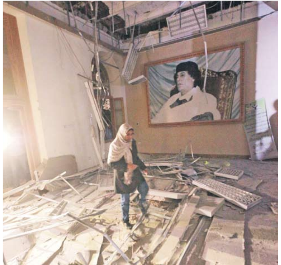
► Навсякъде в Триполи може да се видят разрушени сгради от бомбардировките
