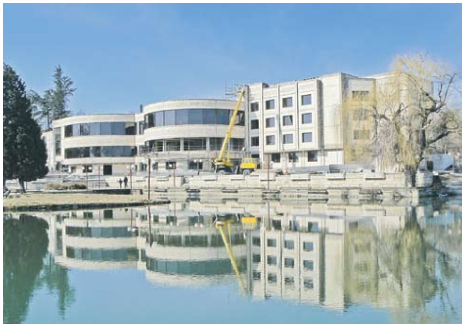
► Главен проектант на сградата е проектантско бюро “Форум” на арх. Иван Иванов. Основен изпълнител на строителните работи е “Металик” АД
