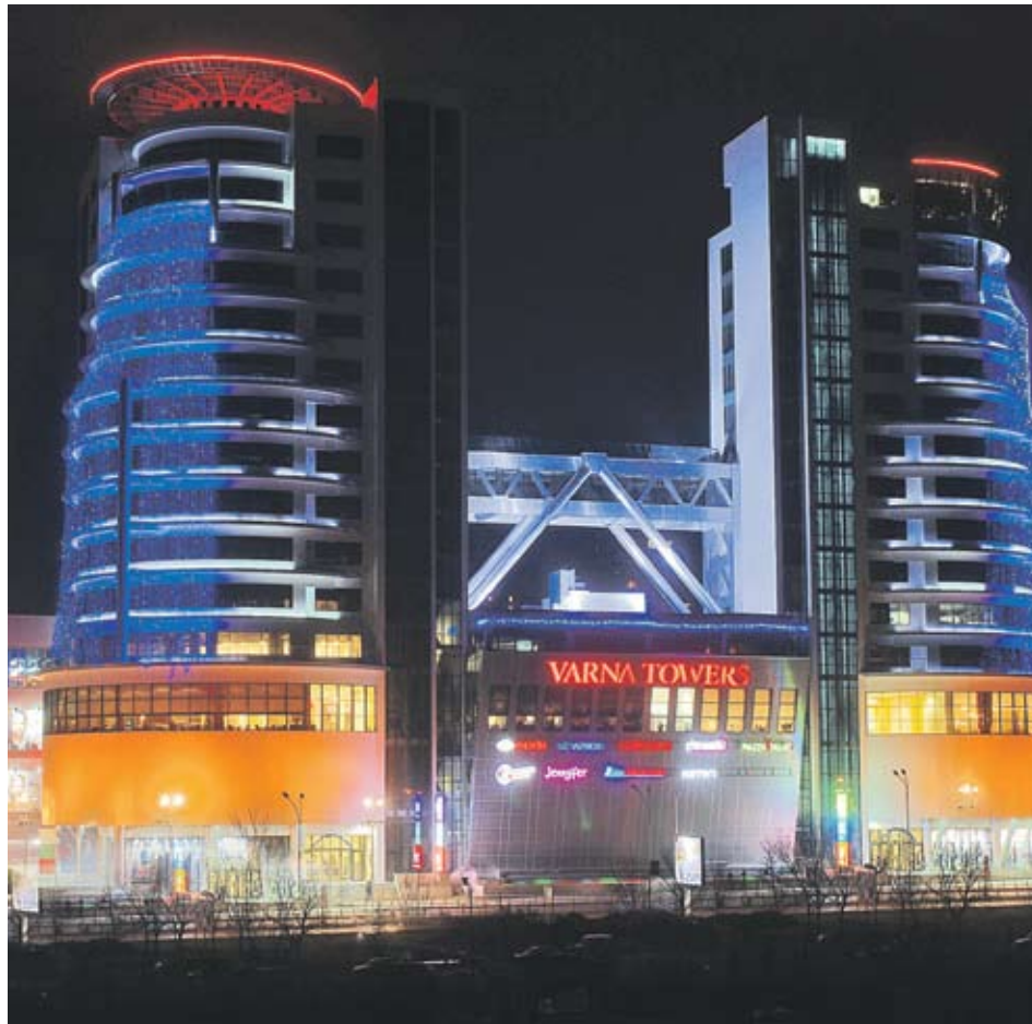
► С около 50% са свалени цените на наемите във Varna Towers заради кризата
