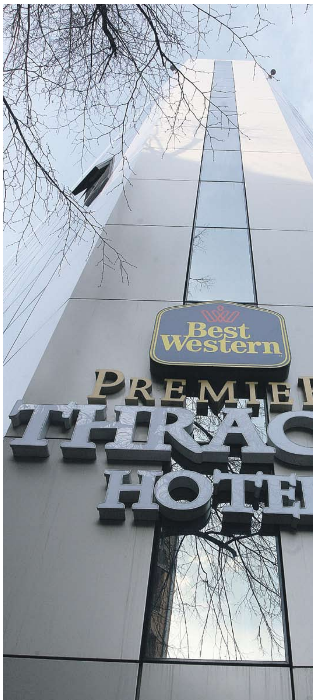
▶ Хотел „Тракия“ в София е най-новият обект от веригата „Бест Уестърн“ в България, Балканите от по-високия сегмент на веригата Premier
