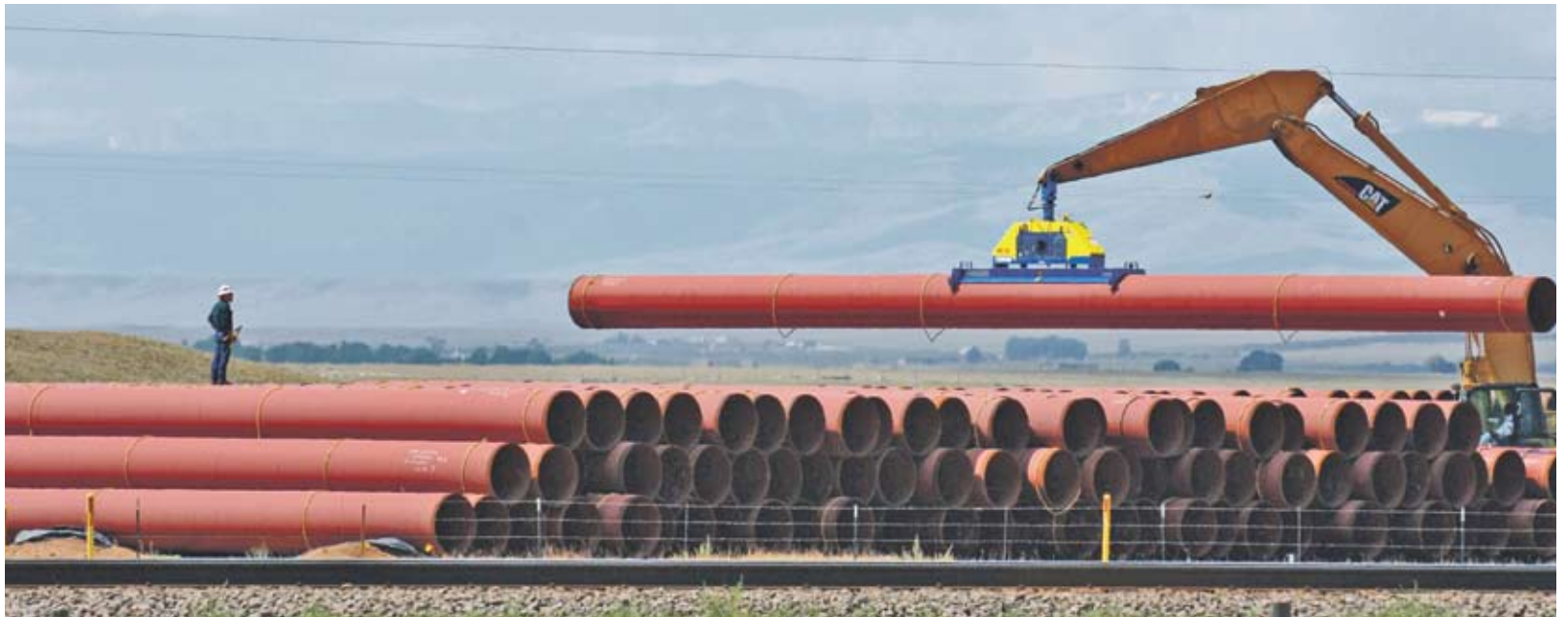
► Досегашната позиция на правителството е, че ще вземе решение за нефтопровода, след като излезе екооценката. Обещанието е, че при отрицателна оценка той няма да се строи
