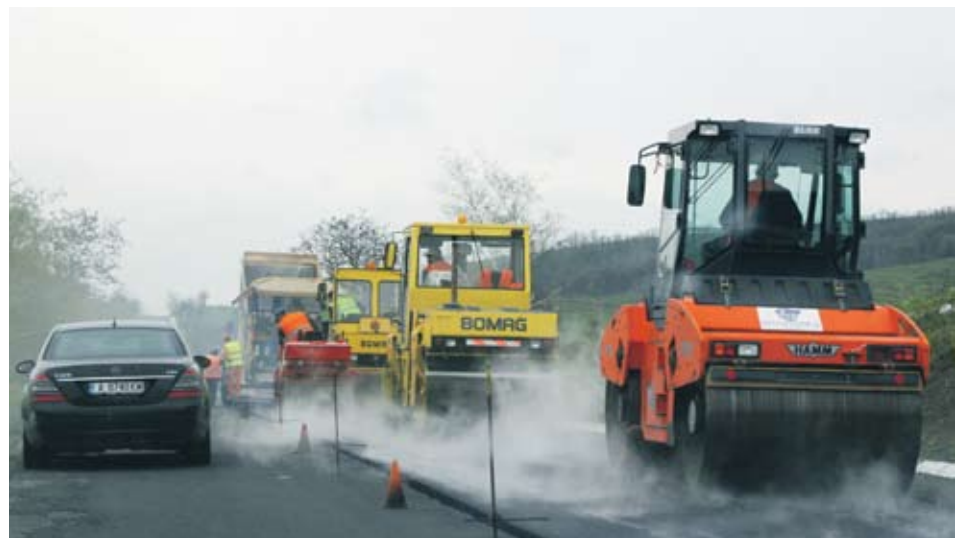
► Холдинг "Пътища" ще ремонтира едновременно двата участъка
