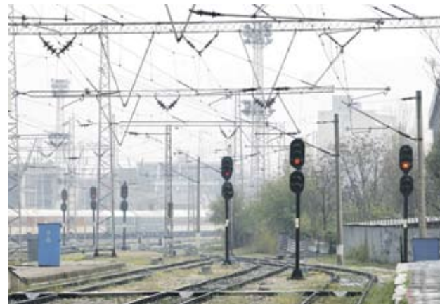
► Крайният срок за подаване на оферти за ремонта на жп линията Пловдив - Бургас е 8 ноември
