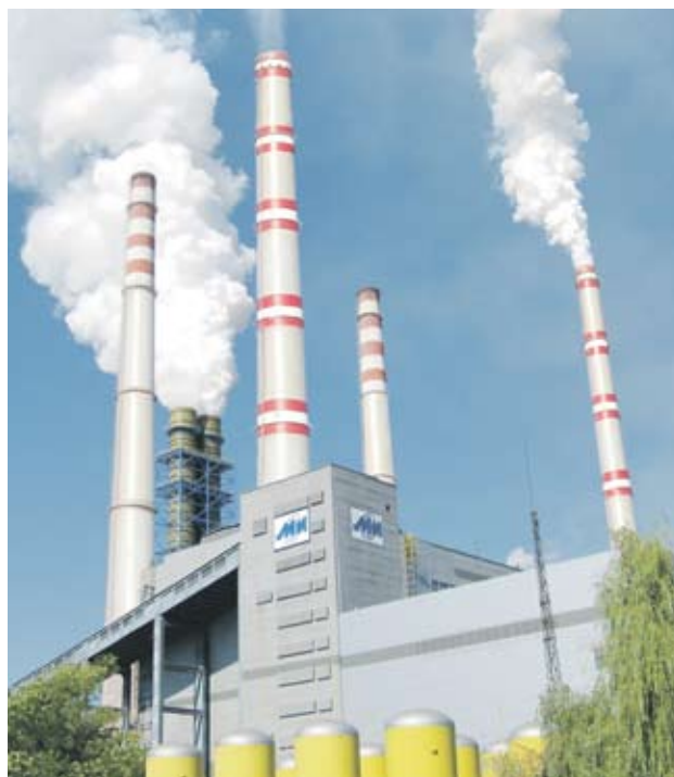
► „ТЕЦ Марица Изток 2“ ЕАД извършва голяма част от ремонтните работи в централата със собствен персонал
