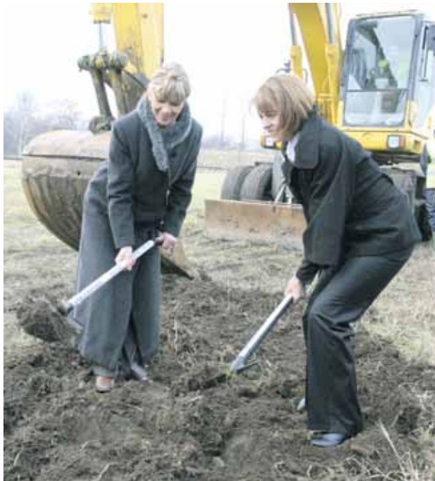
▶ Нона Караджова и Йорданка Фанджкова направиха първа копка на реконструкцията на станцията в Кубратово
